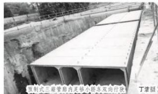
预制三箱管廊内足供小轿车双向行驶 丁浩摄
