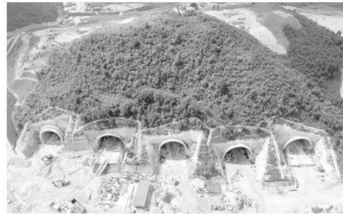
图为七星数据中心主体,其由山洞数据中心、洞外扩展中心和开发生活配套区构成。视觉中国
